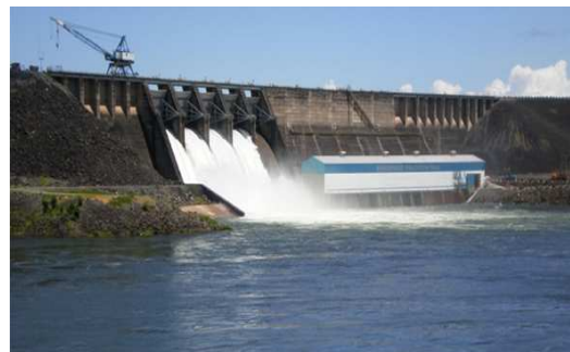
Figuur 3 Afobakka waterkrachtcentrale
